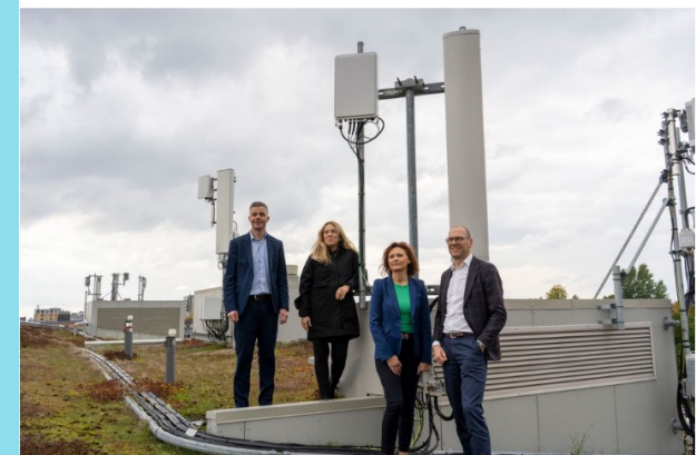
Sentrale bredbåndsselskaper fra hele Norge blir med i et nyopprettet tårnselskap som skal bidra til å bygge Norges raskeste 5G-nett. Her representert ved noen av de største selskapene foran en av Ice' eksisterende 5G basestasjoner i Nydalen i Oslo. Fra venstre: Odd-Eirik Grøttheim, direktør NTE Telekom, Toril Nag, konserndirektør tele i Lyse samt styreleder i Ice og Altibox, Mariann Salvesen, direktør Haugaland Kraft Fiber og Ola Børke, direktør i Eidsiva Bredbånd. (Foto: Sebastian Storvik).
